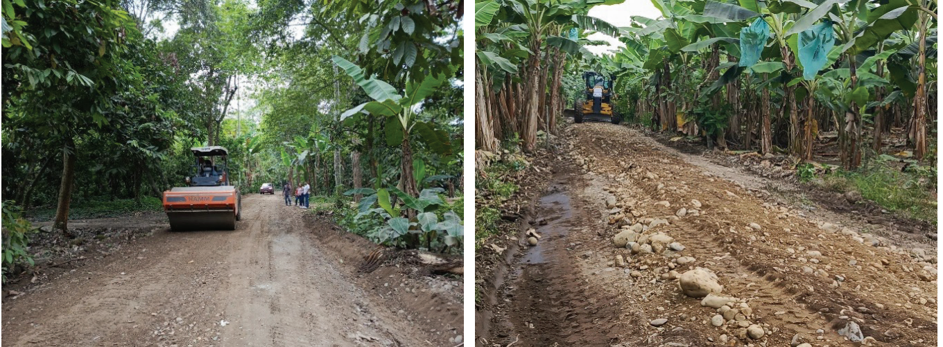
Figura 46. Mantenimiento de vías rurales
